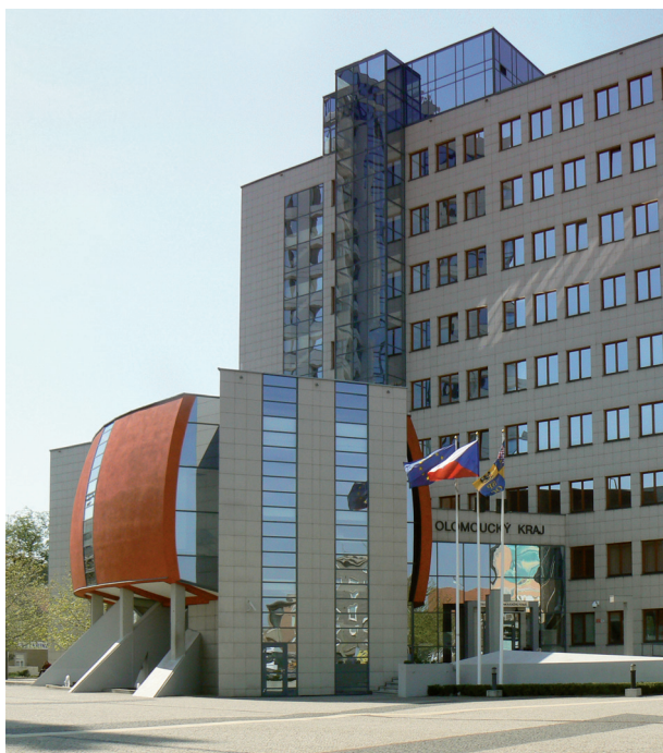
Sídlem Krajského úřadu v Olomouci je nová budova na ulici Jeremenkova. (Foto Alžběta Brychtová)
